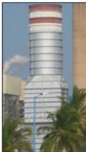
Figura 1. Chimenea de la Termoeléctrica de Tuxpan.
