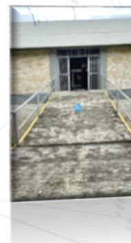
Figura 2. Salida de emergencia de edificio B, Fuente ITST
